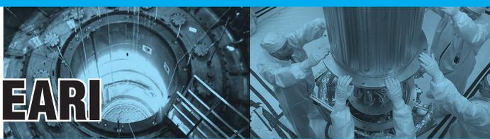
Il reattore nucleare è il sistema in cui avviene ed è controllata la reazione di fissione nucleare che libera energia sotto forma di calore. L'energia così prodotta nel reattore viene estratta da un fluido, generalmente acqua, per produrre vapore che, espandendosi in una turbina, genera energia meccanica e quindi elettrica.
