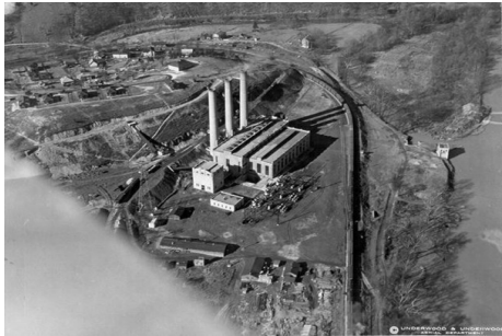
La centrale a carbone di Glen Lyn (Virginia), nella foto del 1925, entrò in funzione nel 1919, producendo 15 Mw, sufficienti per le miniere di carbone e piccoli villaggi nei dintorni. Le unità 2 e 3, da 20 Mw si aggiunsero tra il 1920 e il 1924. Il gruppo 4 da 25 Mw entrò in funzione nel 1927. Nel 1944 fu lavolta dell'unità 5 (95 Mw), mentre l'unità 6 (240 Mw) entrò in servizio nel 1957. https://aepretirees.com/2015/06/08/glen-lyn-plant-a-history-of-service/
