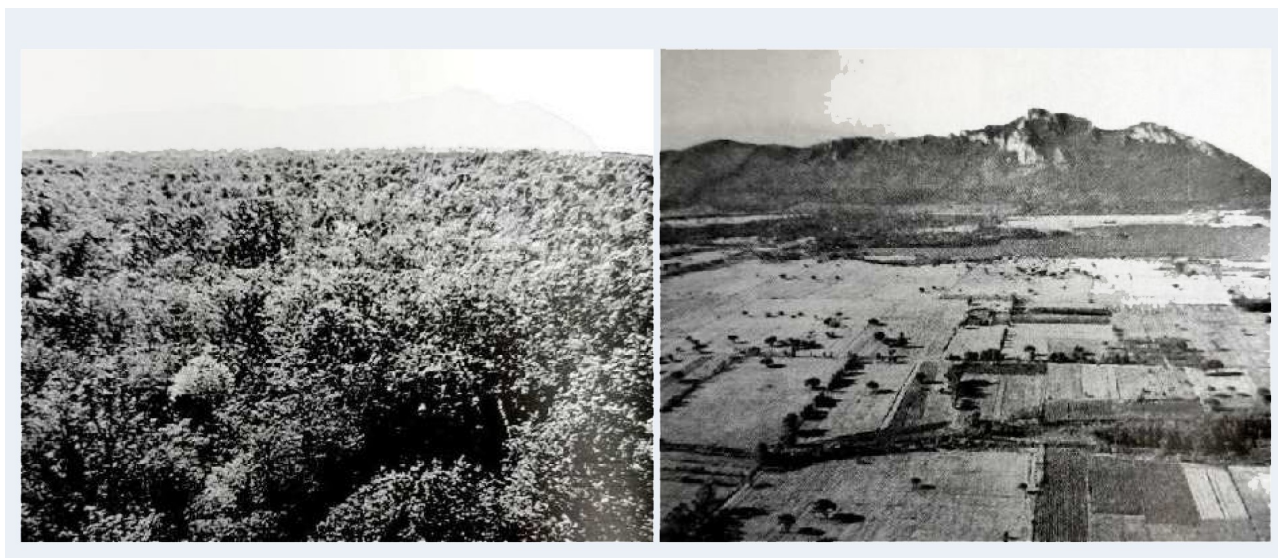
La selva di Terracina prima e dopo i lavori di bonifica. Fonte Martone 2012
